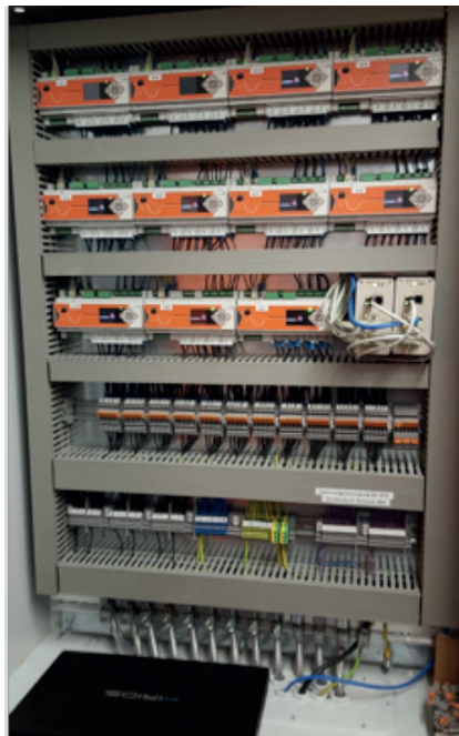
Bild 1 Überwachung vieler Abgänge durch den kompakten Power Quality Analyser PQI-DA smart; hier elf Geräte
